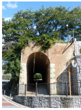
レンガ造りの道路隧道
