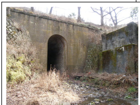
(上) 大久保沢の河川隧道
